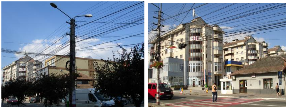
Foto nr. 29 - Cabluri vizibile pe stâlpii de iluminat public în zona centrală.
